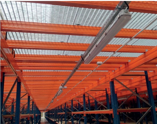
Modernizacja oświetlenia w hali RAVI w Miutowie
