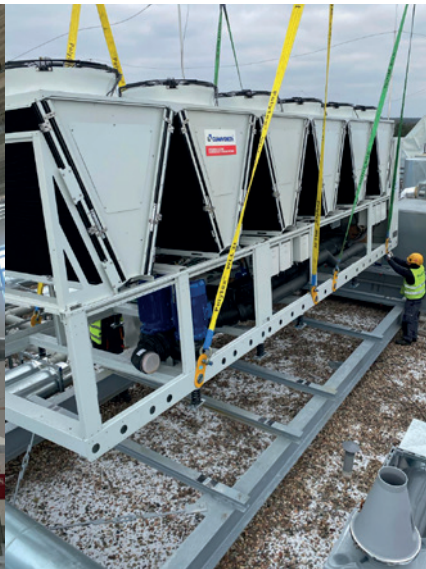
Agregat wody lodowej
