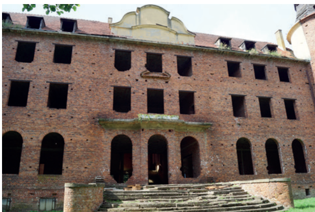
Fot. 3. Widok obecny elewacji pokazanej na rysunku 1. Otwory okienne i drzwiowe, zwieńczone półkoliście w przyziemiu i prostokątne na wyższych kondygnacjach, tworzą regularny, osiowy rytm elewacji (fot. M. Kanoniczak)
