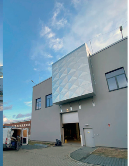
Oplaszczowanie kanału wentylacyjnego
