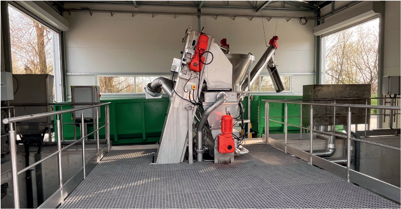
Fot. 1. Hala do gromadzenia piasku i skrutek nad komorą kratopiaskownika
