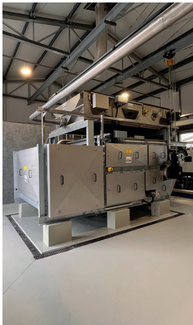
Fot. 5. Budynek stacji mechanicznego zagęszczania i odwadniania osadu z prasą taśmową
