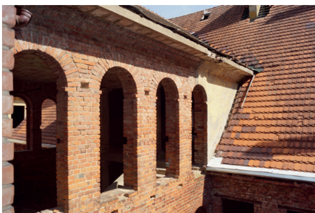
Fot. 9. Mury zewnętrzne, gzymsy i dachy (fot. M. Kanoniczak)
