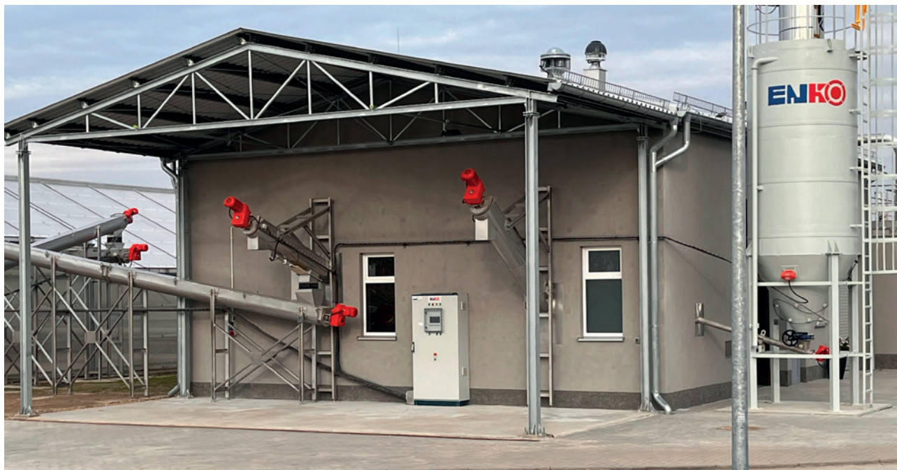
Fot. 6. Budynek stacji mechanicznego zagęszczania i odwadniania osadu z silosem na wapno oraz przenośniki ślimakowe do transportu osadu odwodnionego po prasie taśmowej
