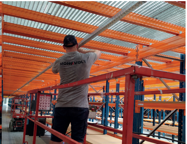
Modernizacja oświetlenia w hali RAVI w Miutowie
