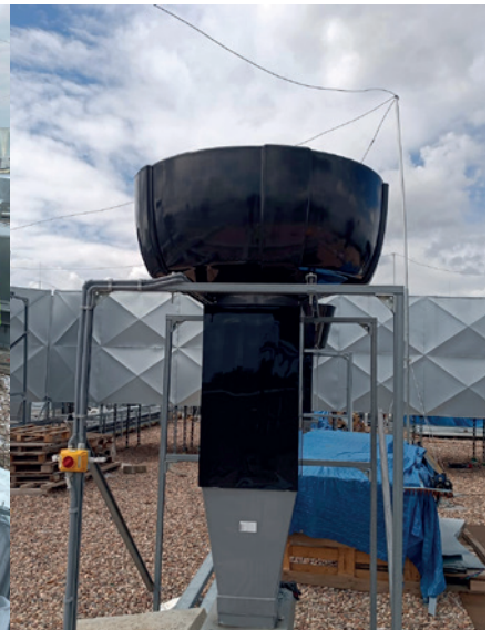
Układ chemoodpornej wentylacji wyciągowej
