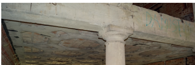
Fot. 5. Podciąg żelbetowy o rozpiętości 7,71 m podpierający strop westfalski (fot. M. Kanoniczak)
