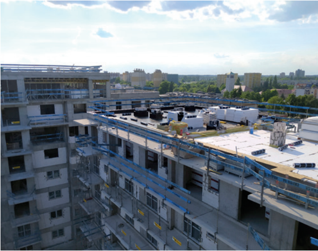
Budynki mieszkalno-handlowo-usługowe przy ul. Piątkowskiej w Poznaniu
