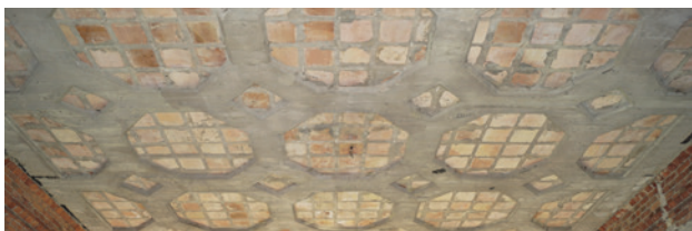
Fot. 7. Żelbetowy strop kasetonowy płaski z wypełnieniem ceramicznym (fot. M. Kanoniczak)
