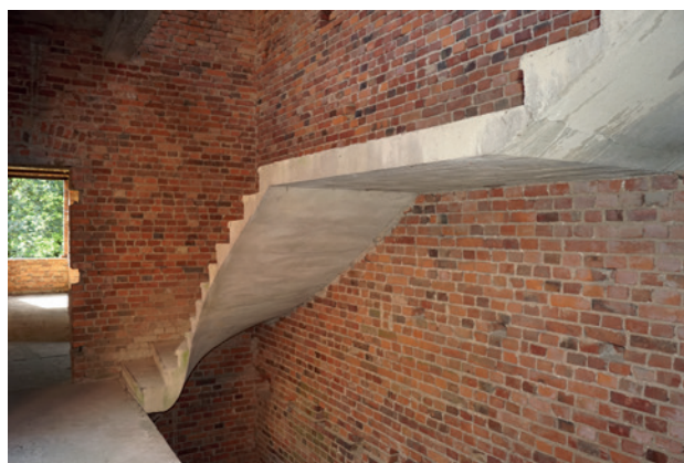
Fot. 6. Wspornikowe, płytowe schody żelbetowe o szerokości 1,2 m przy wewnętrznych dziedzińcach zamku (fot. M. Kanoniczak)
