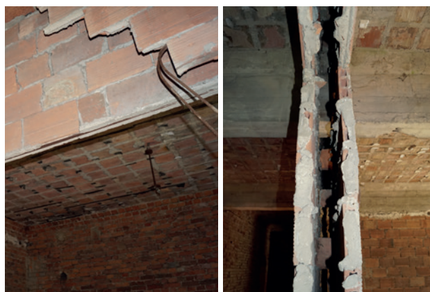
Fot. 8. Zespolone ścianki działowe piętra (fot. M. Kanoniczak)
