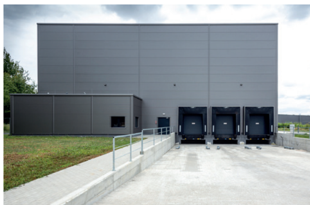
Hala magazynowa Agmamito w Swarzędzu, widok od strony doków przeładunkowych. Autor: Igor Drozdowski.
