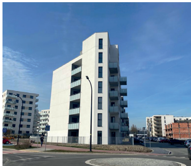
Budynek B5 na ul. Daszyńskiego
