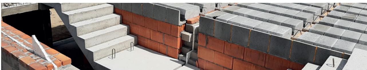
Bierzglińki – strop Teriva oraz schody prefabrykowane ze spocznikiem dolnym
